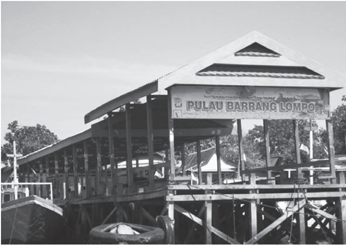
定期船が発着するバランロンボ島の栈橋
